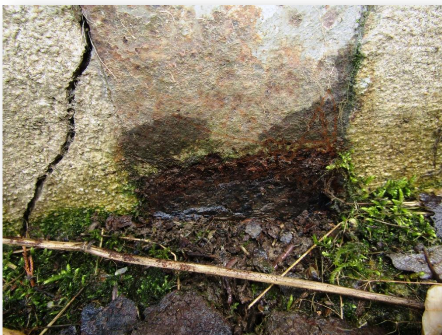
Photo n°11 : pied de poteau en cours de corrosion.
