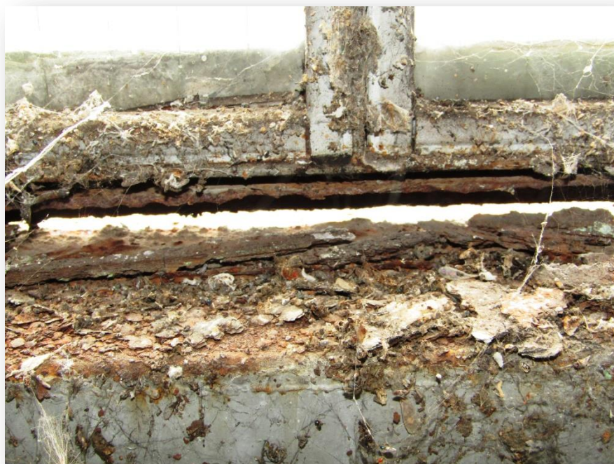
Photo n°16 : corrosion soudures lisses baies/poteaux.
