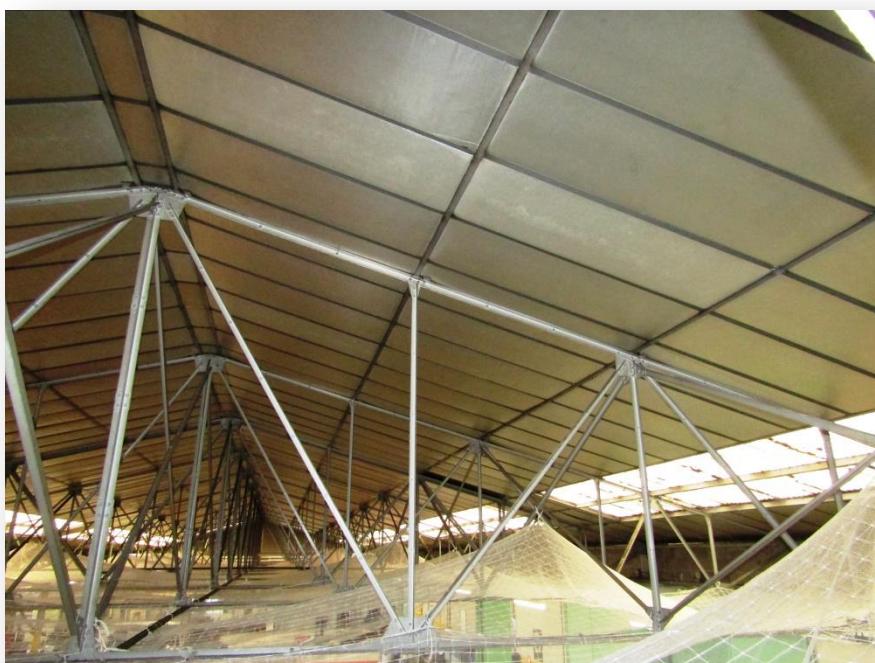
Photo n°1 : vue partielle d'une ferme treillis.
