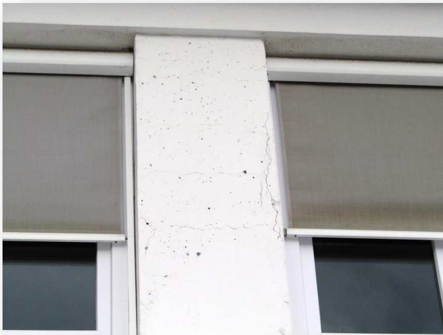
Photo n°36 : façade bureaux : poteau béton fissuré.
