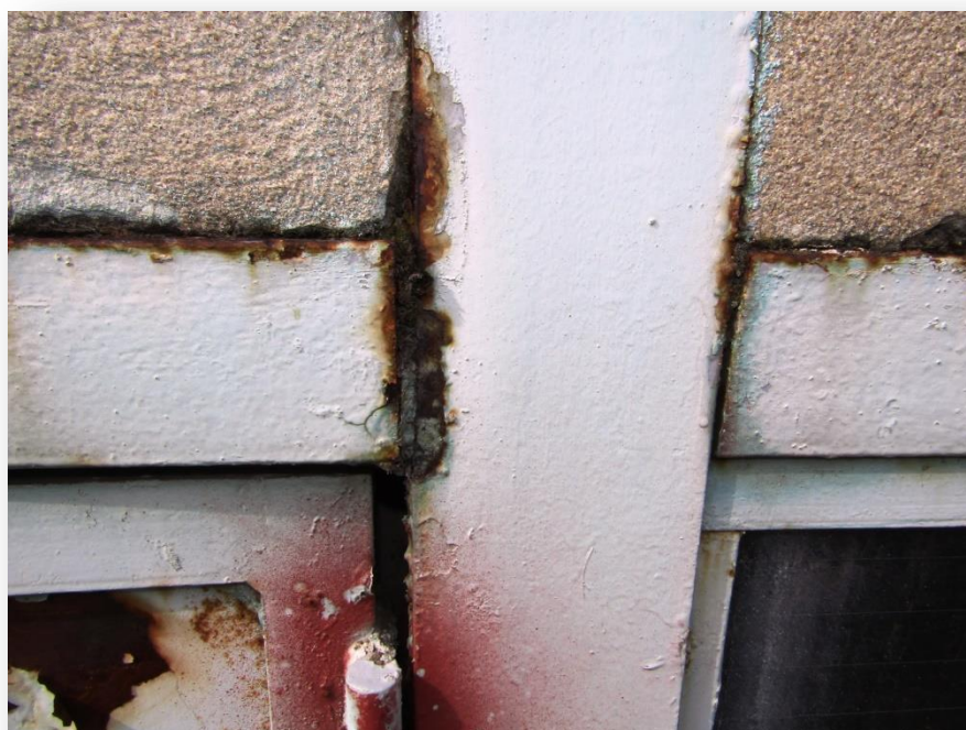
Photo n°14 : corrosion soudures lisses baies/poteaux.
