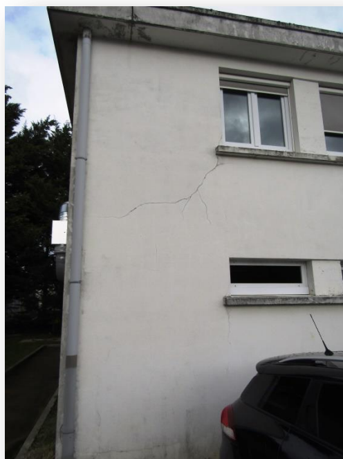
Photo n°30 : façades bureaux : fissuration poteaux/allèges.
