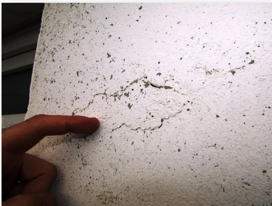
Photo n°36 : façade bureaux : poteau béton fissuré.
