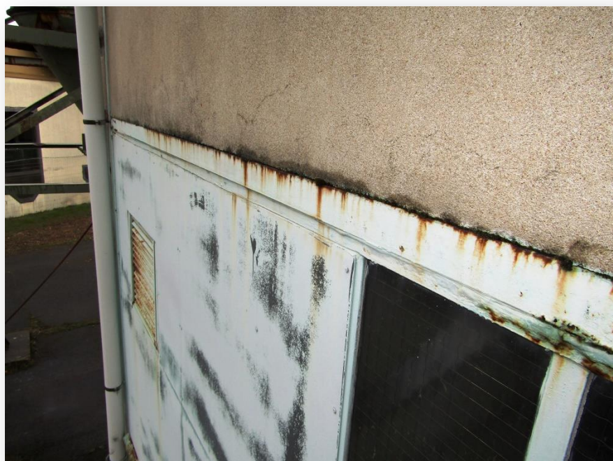
Photo n°18 : corrosion de l'ossature des baies.
