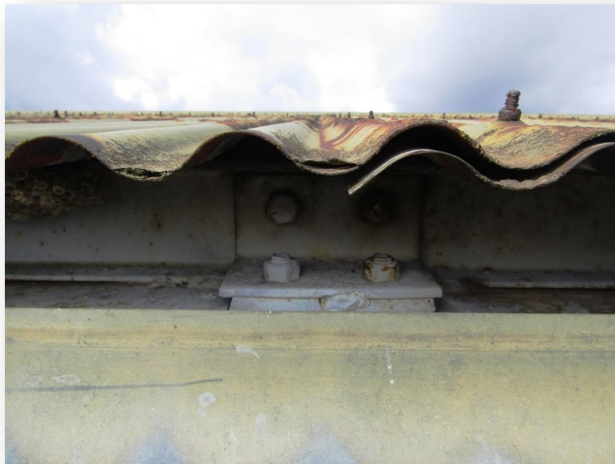
Photo n°26 : toiture : bac acier corrodé.
