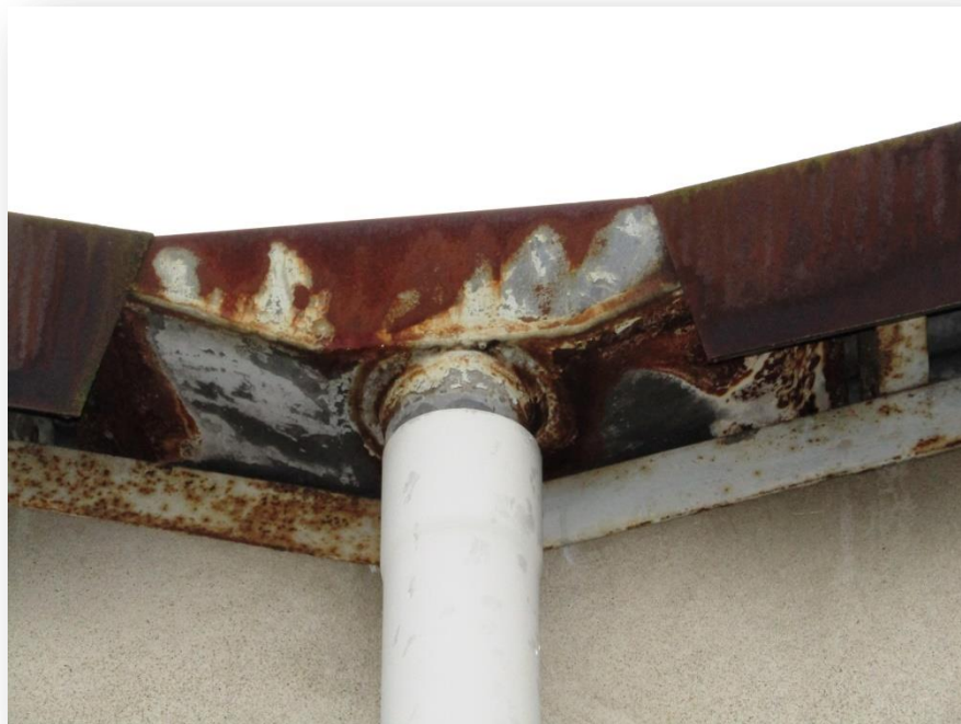
Photo n°24 : chêneaux corrodés.
