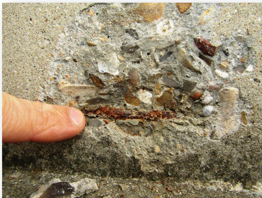
Photo n°34 : acier apparent corrodé sur façade bureaux.
