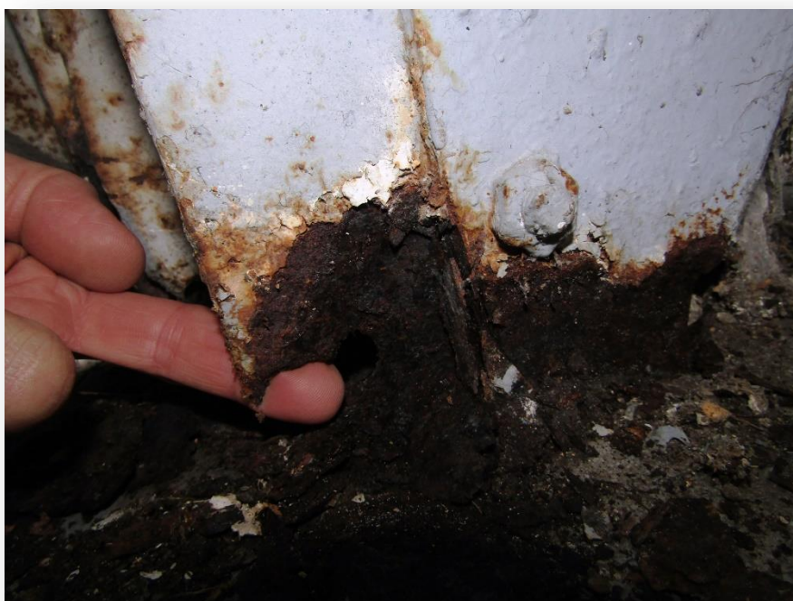
Photo n°9 : pied de poteau de façade : corrosion feuilletante.
