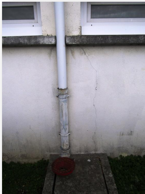
Photo n°28 : façades bureaux : fissuration poteaux/allèges.
