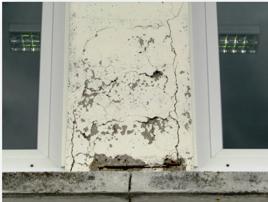
Photo n°38 : façade bureaux : poteau béton fissuré.
