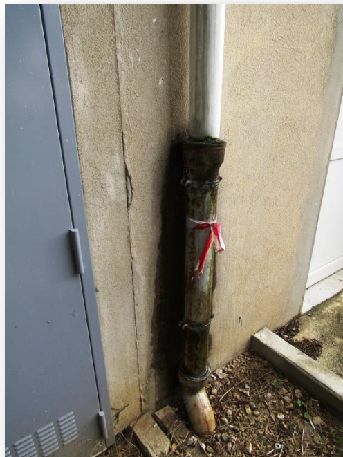
Photo n°40 : bureaux : descente EP bouchée.
