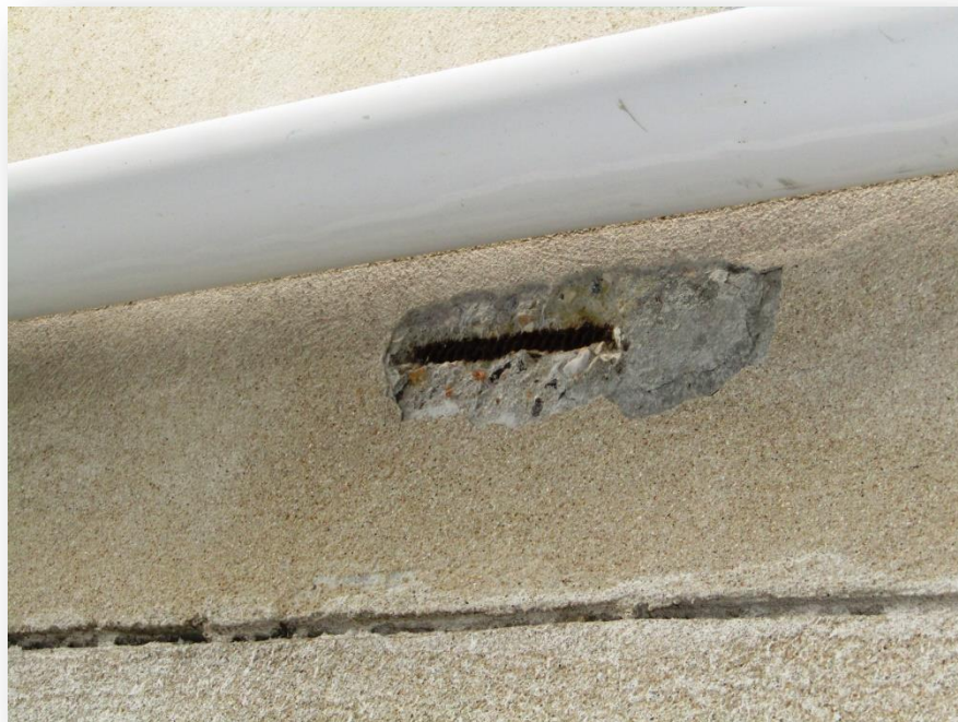
Photo n°34 : acier apparent corrodé sur façade bureaux.
