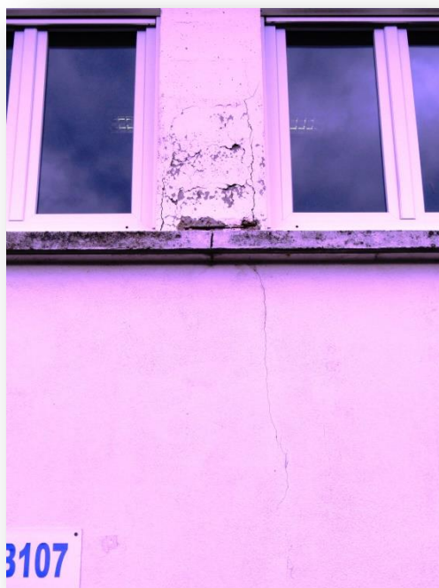
Photo n°28 : façades bureaux : fissuration poteaux/allèges.
