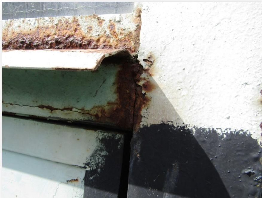
Photo n°14 : corrosion soudures lisses baies/poteaux.
