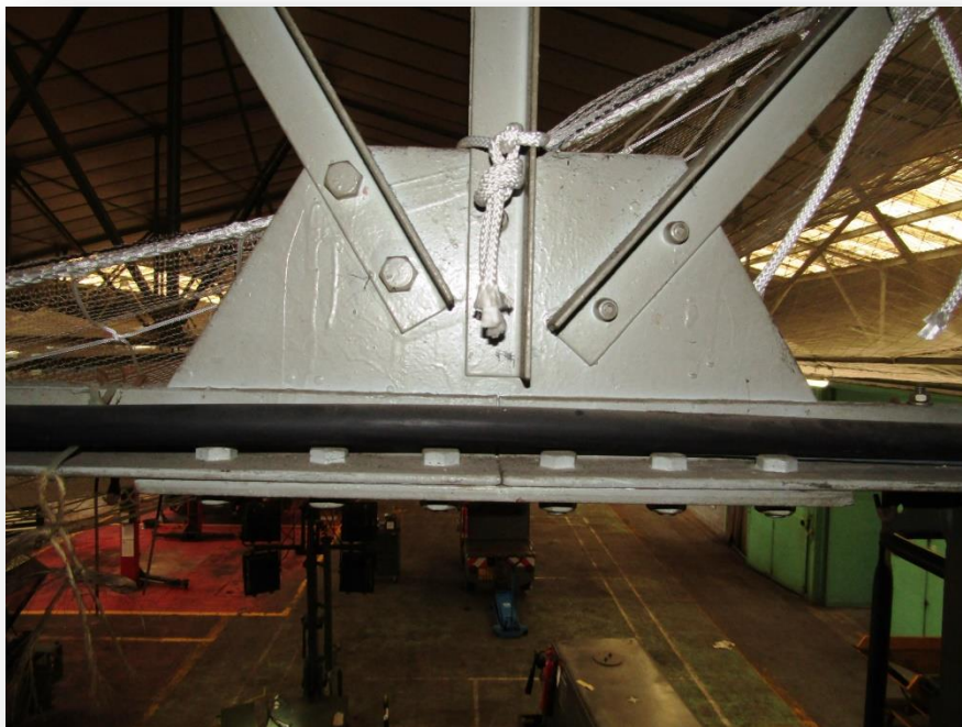
Photo n°3 : gousset d'assemblage diagonales/montants/membrure inférieure.
