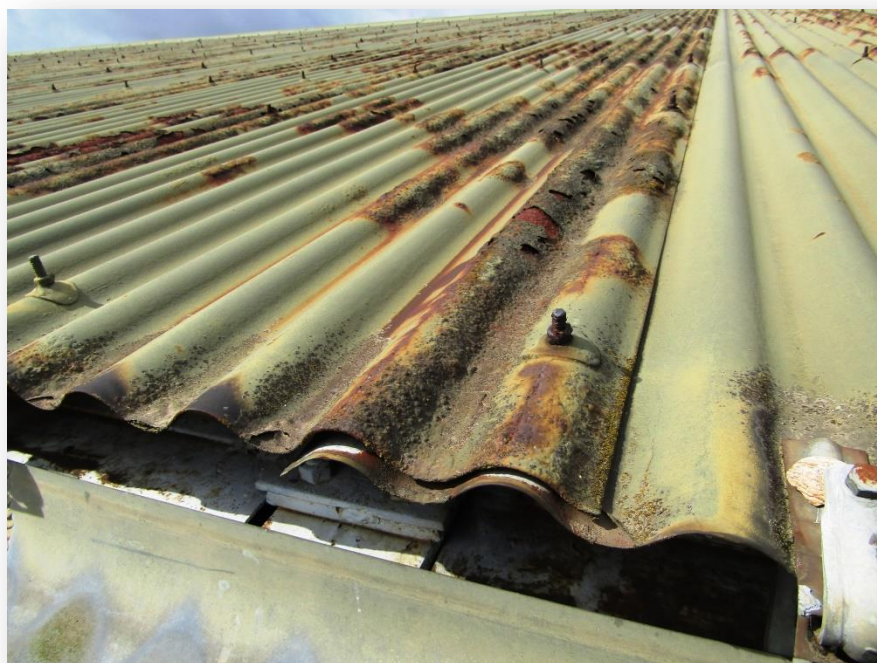
Photo n°24 : chêneaux corrodés.
