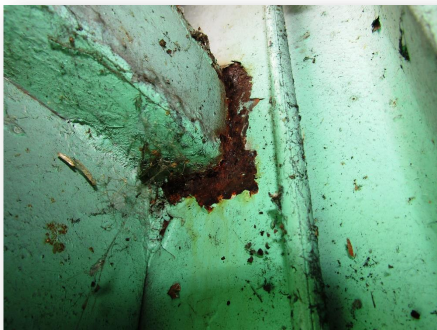
Photo n°13 : pied de poteau en cours de corrosion.
