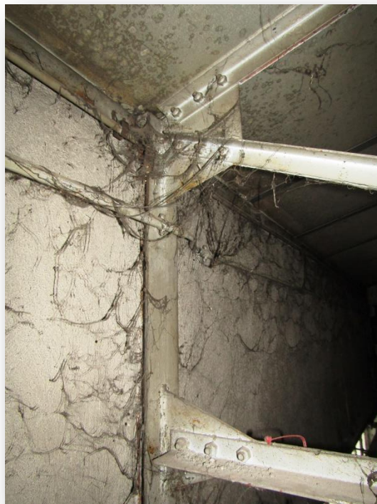
Photo n°5 : fixation d'une ferme sur un poteau.
