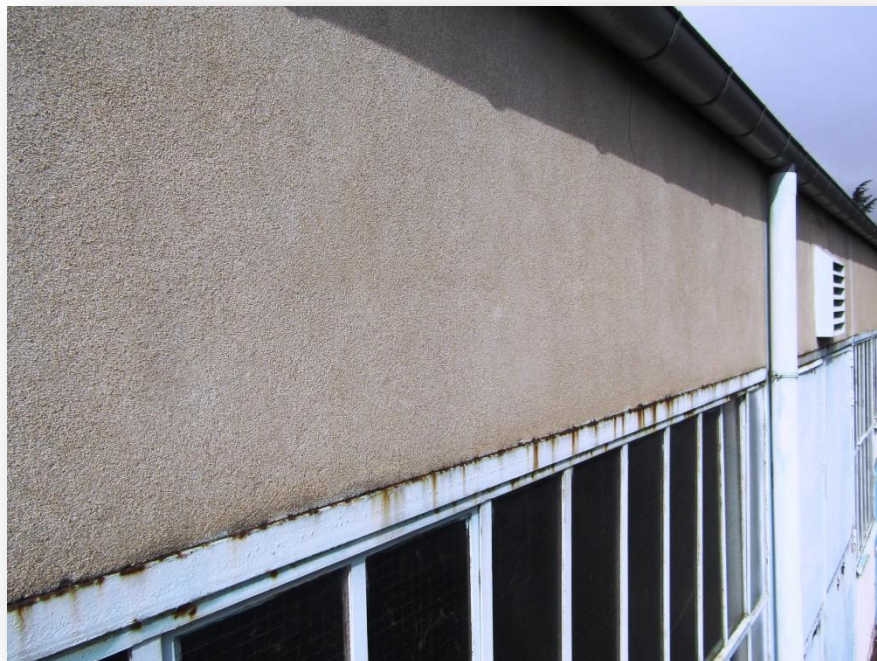
Photo n°18 : corrosion de l'ossature des baies.
