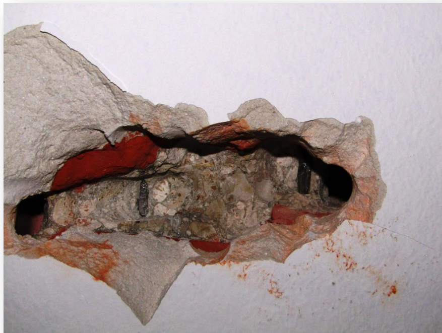
Photo n°42 : bureaux : sondage sur plancher terrasse.
