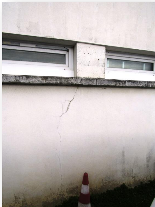
Photo n°32 : façade bureau : fissure angle gauche, proche réseau EP.
