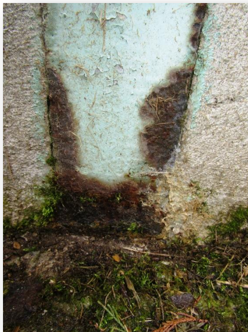
Photo n°13 : pied de poteau en cours de corrosion.
