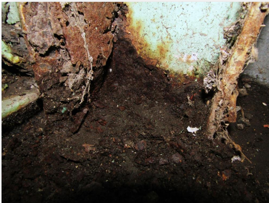
Photo n°7 : pied de poteau de façade : corrosion feuilletante.
