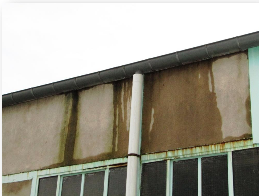
Photo n°20 : corrosion de l'ossature des baies.
