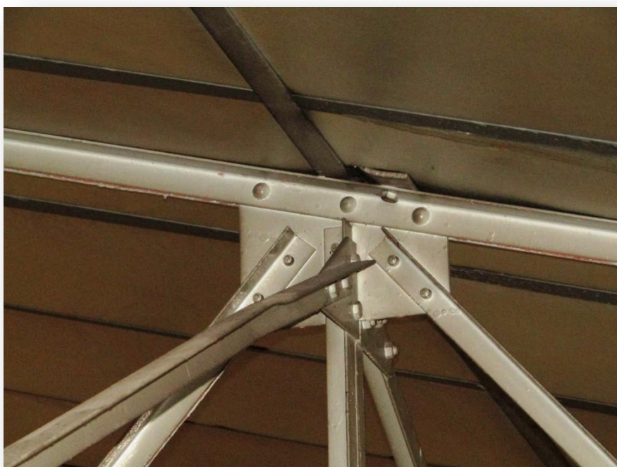
Photo n°3 : gousset d'assemblage diagonales/montants/membrure inférieure.
