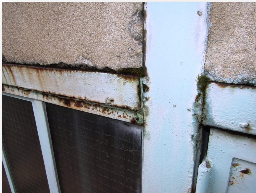
Photo n°20 : corrosion de l'ossature des baies.
