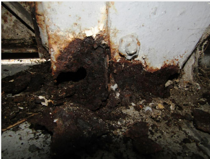
Photo n°9 : pied de poteau de façade : corrosion feuilletante.
