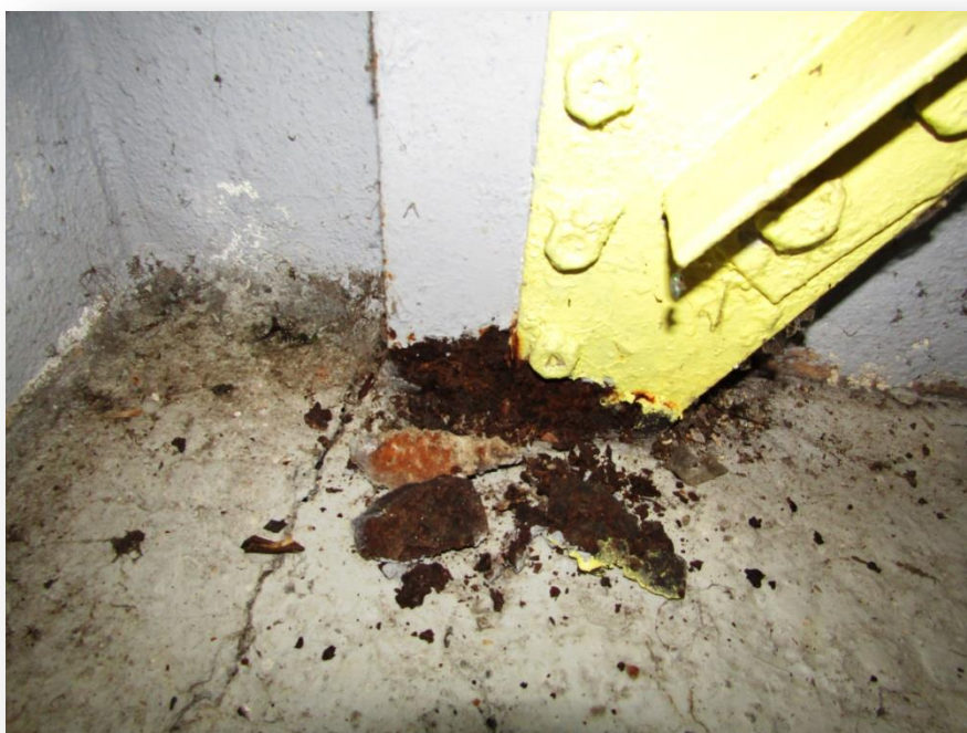
Photo n°7 : pied de poteau de façade : corrosion feuilletante.
